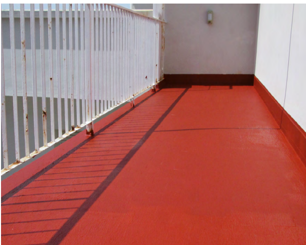
4. Lavoro finito. Possibilità di: a) pavimentare con piastrella b) rivestire con strato pedonabile antiusura in resina ACRYTOP c) lasciare a vista
