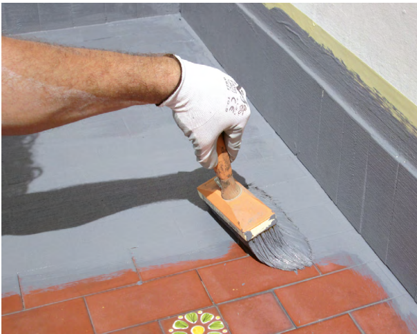
1. Applicazione di primer MULTIFIXO 100 su balcone pavimentato
