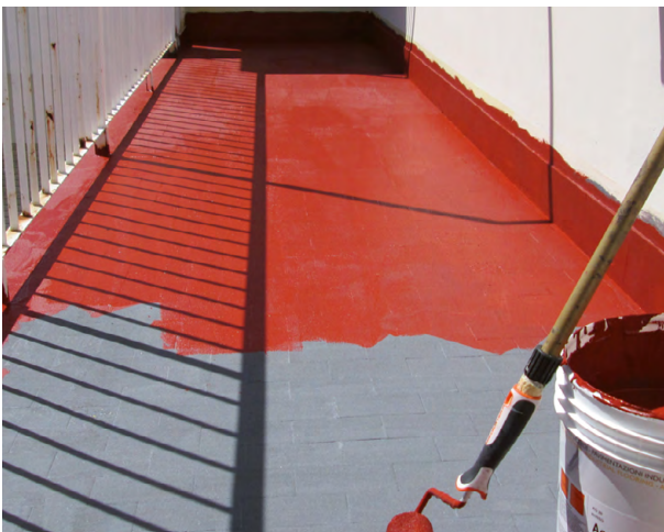
2. Applicazione della prima mano di ACRYROOF PLUS FIBRO
