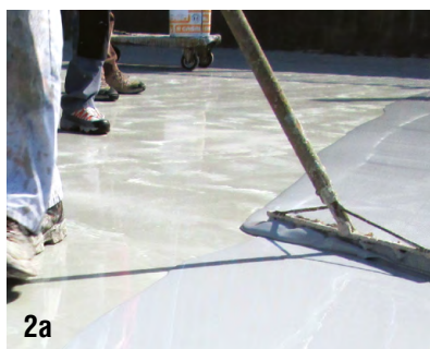
2a. Dettaglio applicazione con racla calibrata (vedi pag. 63) 2b. Posa dell'autolivellante impermeabile e carrabile POLYROOF
