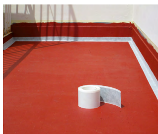
3. Impermeabilizzazione giunti e raccordi con CASABAND SA
