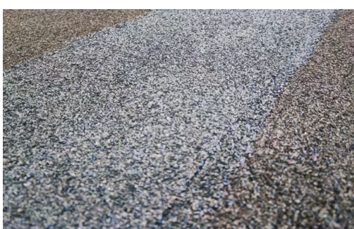
4. Semina a fresco di ardesia in scaglie su ultima mano abbondante di DERMARUBBER S/P, come protezione ai raggi UV
