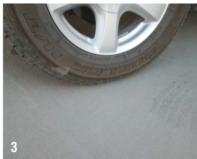
3. Pavimentazione in esercizio 4. Lavoro finito
