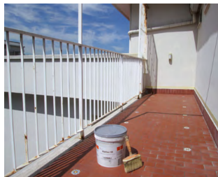
1. Applicazione di primer MULTIFIXO 100 su balcone pavimentato
